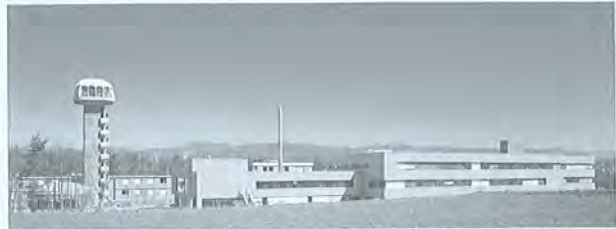
Bild 1: Bundesamt für Metrologie METAS in Wabern, im Vordergrund die 2001 eröffneten Laborgebäude.
